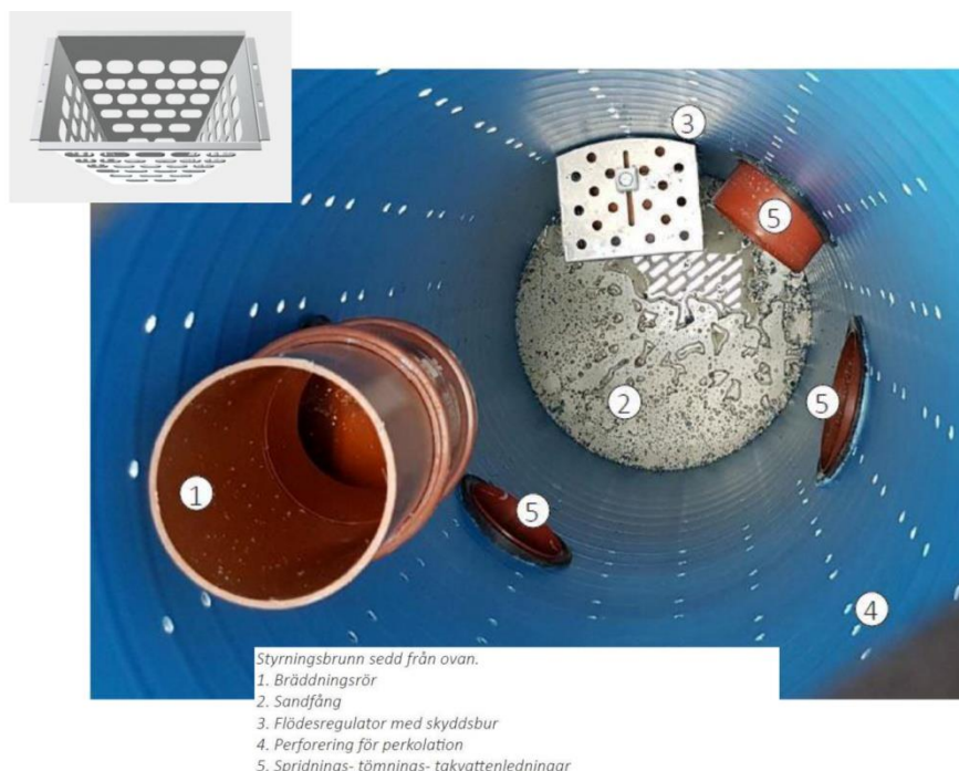
Obr.: Rozdělovací šachta.
