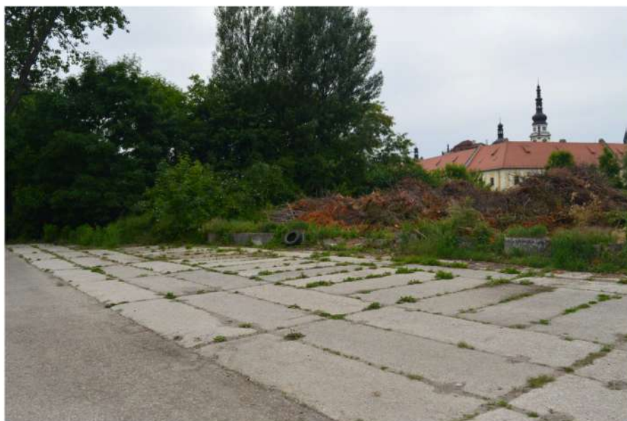
pohled na betonové panely
