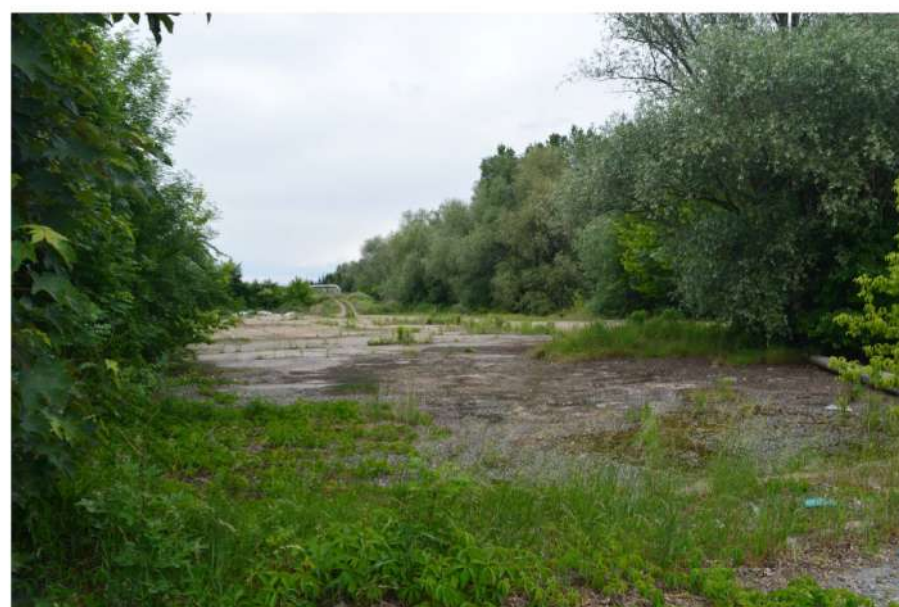
pohled na plochu s betonovými panely
