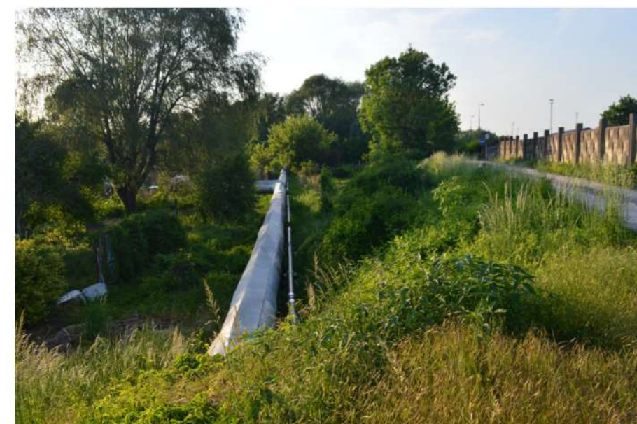
pohled na parovod v zahrádkářské kolonii
