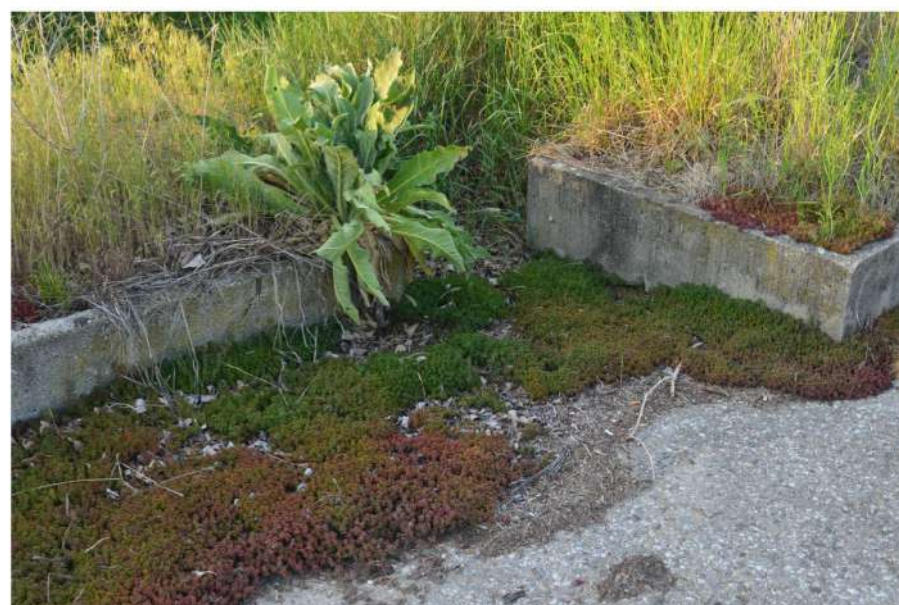
pohled na detail již probíhající sukcese s betonovými prvky
