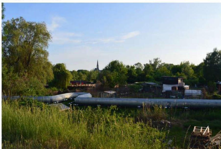
pohled na parovod v zahrádkářské kolonii
