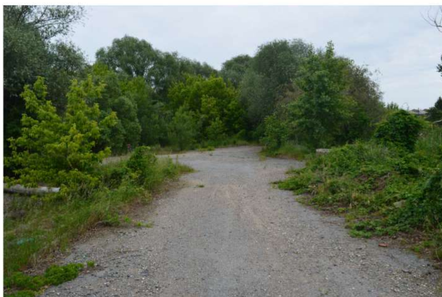
pohled na plochu se zbytky betonu a asfaltu
