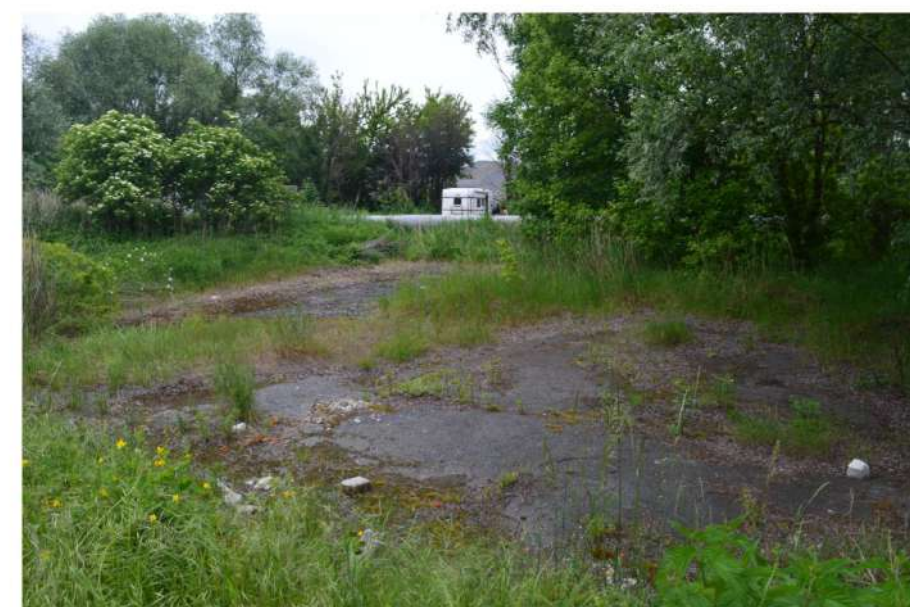
pohled na plochu se zbytky asfaltu
