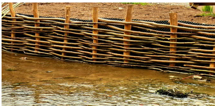
Zápleťový plůtek – vrbové proutí na dubových kolících
